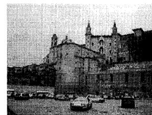
写真2 現在の修復状況
