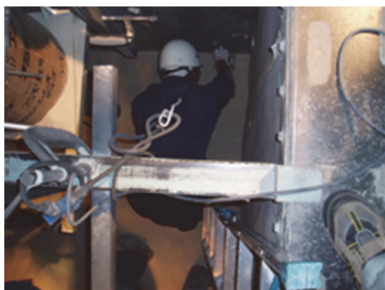
(c) 珪砂撒出し状況
