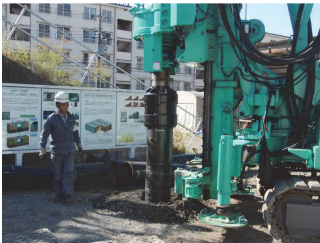
図 6-5 鋼管杭の打設状況
