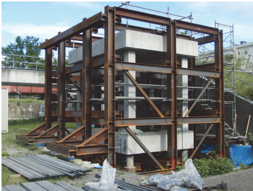
図 6-15 反力架台の設置
