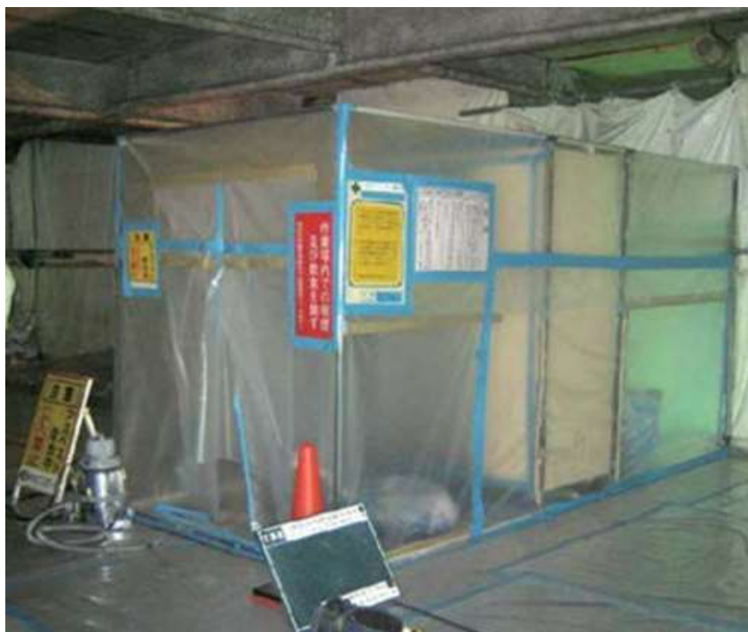
図 2.2 セキュリティゾーン外観
