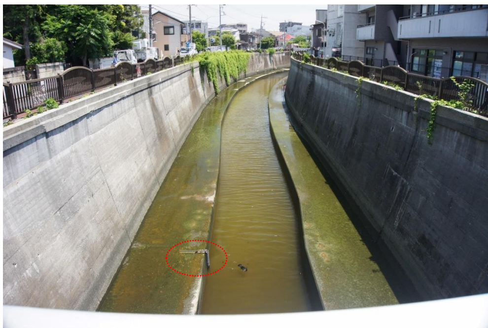
写真 5-4 設置状況（養源寺橋）
