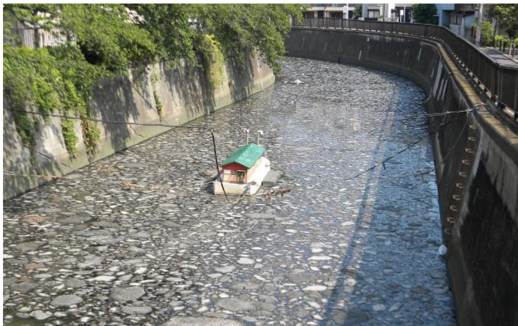
写真 2-1 スカムの発生状況
