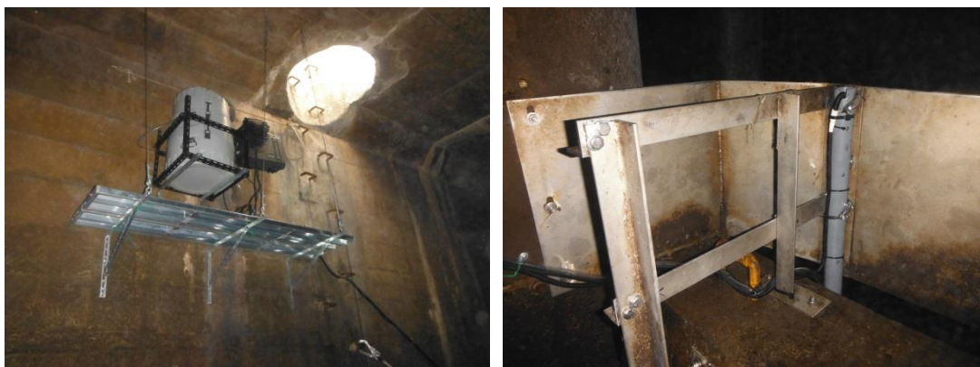
図 3-7 調査地点① の設置状況
