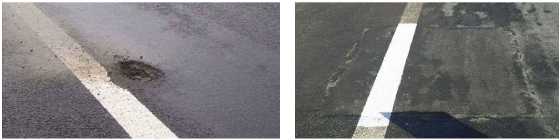
図 3-5-3 ポットホール及び部分的な舗装補修工事
