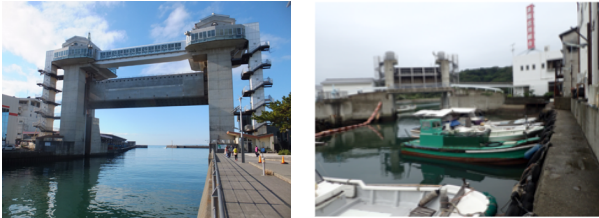
(2016年12月筆者撮影) (2018年9月筆者撮影) 図-1 港口閉鎖方式の水門 (左: 沼津港, 右: 由良港)
