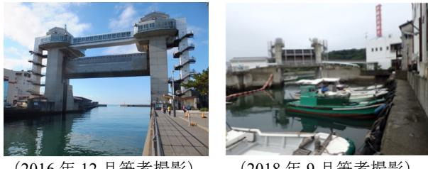
図-1 港口閉鎖方式の水門（左：沼津港、右：由良港）
