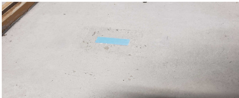
Step 3 Stick the test paper on the concrete surface [手順③ 不透湿性テープをコンクリート表面に貼付する]
