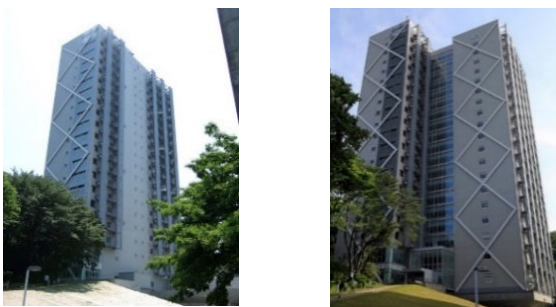
(a) J2 棟(単体時) (b) J2-3 棟(連結後)
