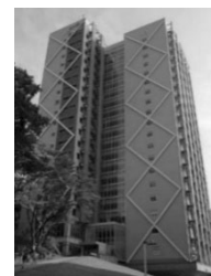
図 1 J2-3 棟の外観
