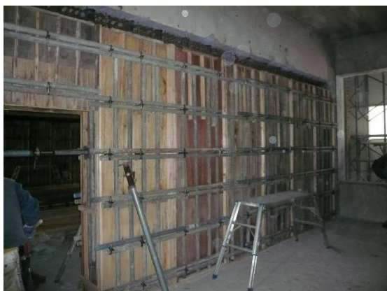
(c)RC 耐震壁工事
