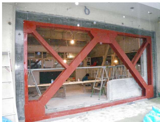
(d)枠付き鉄骨ブレース工事
