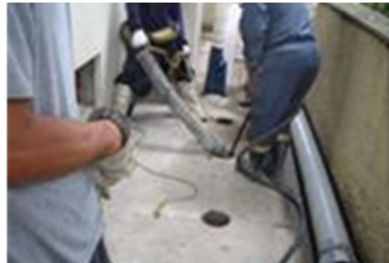
(d)高流動コンクリート打設状況
