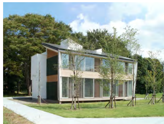
図 1-8 LCCM 住宅デモンストレーション棟
