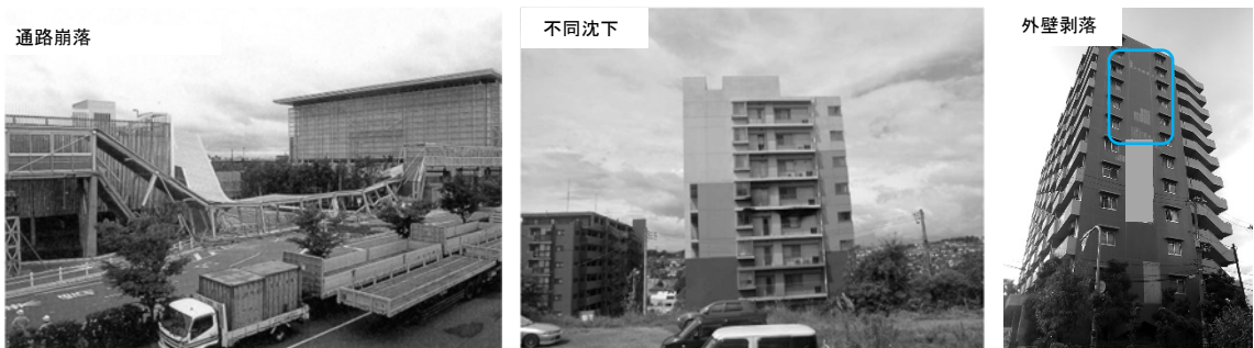
写真 1-1.3 建物完成後の不具合により発展した事件例
