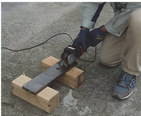
写真-1 縦回転式動力工具による施工状況
