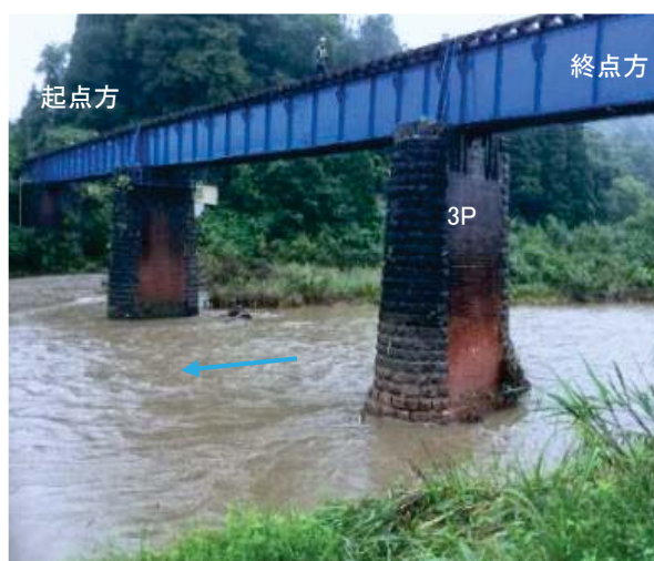
図2-12 角川橋りょう3P周辺の状況
