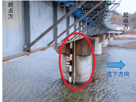
図3-8 計測対象橋脚
