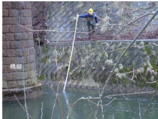
図2-21 河床高さの計測状況の一例
