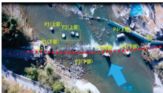
図2-4 流水圧による橋脚の倒壊事例 1)
