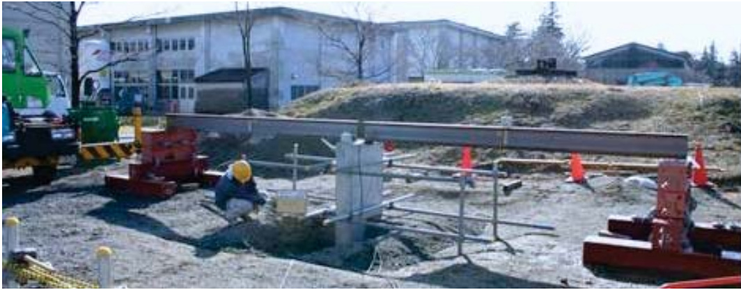
図5-14 模型橋脚の全景 58)
