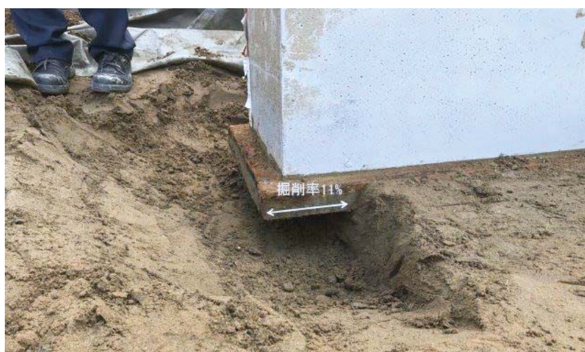
図5-22 底面掘削状況 104) (1P 橋脚・底面掘削率11%)
