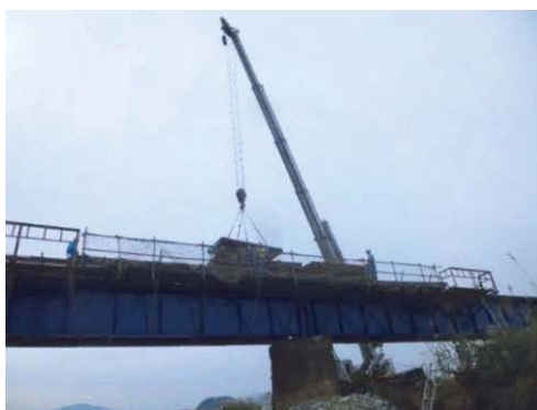
図2-23 敷鉄板による載荷試験の例 46)
