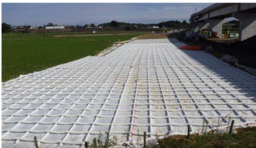
図 1.1.1 格子状補強シートの施工状況例（芦森工業（株）提供）
