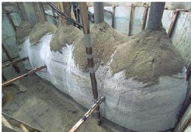
図 1.2.1.15 凍結工法で造成した凍土の様子
