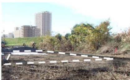
② シート材敷設
