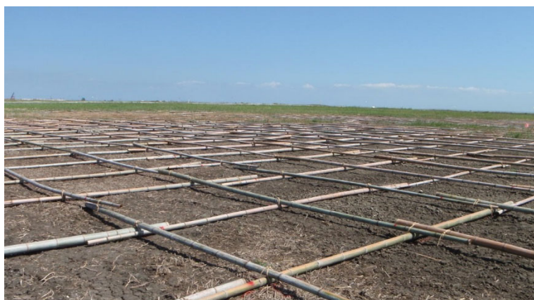
図 2.4.3.1 竹柵工法の実施例（図 1.2.2.5 再掲）
