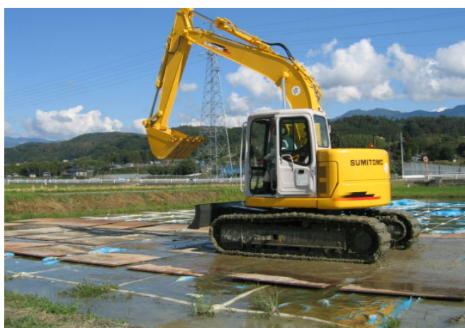
図 2.4.3.9 軟弱な水田における重機走路の設置
