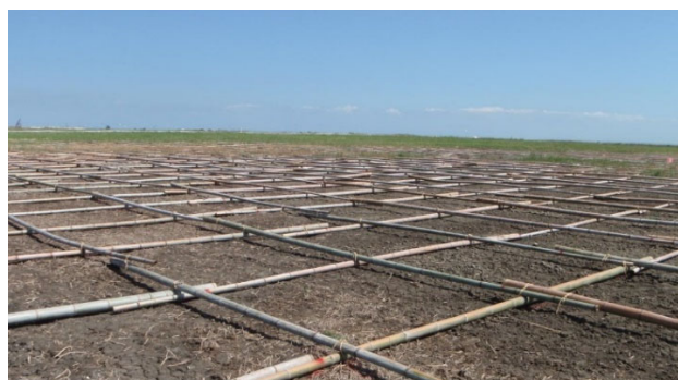
図 1.2.2.5 竹柵の敷設状況例
