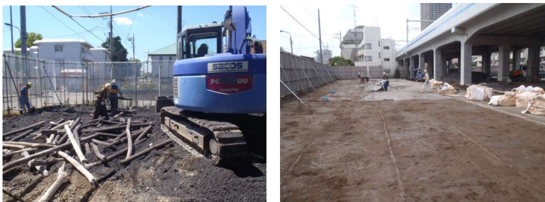
図 4.4.2.12 格子状補強シート撤去作業の状況
