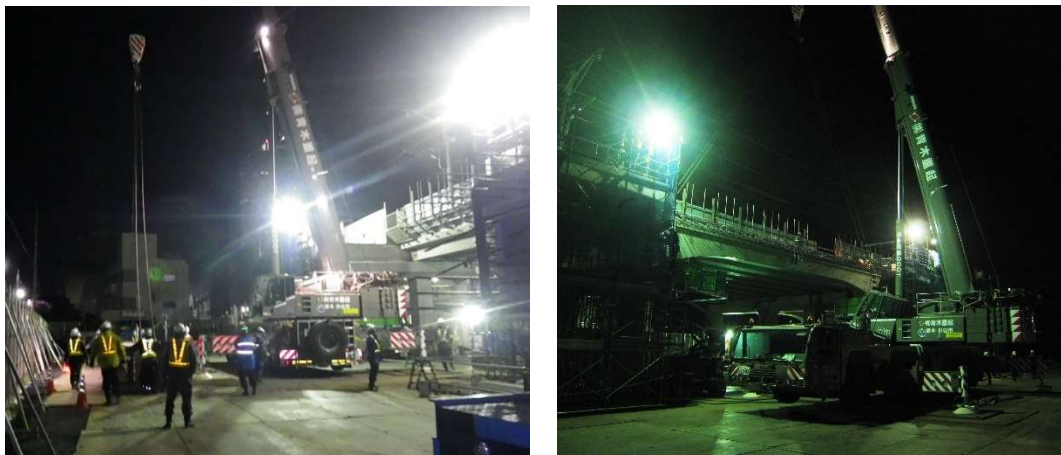
図 4.4.2.11 PC 桁架設作業の状況
