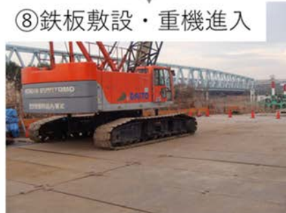
図 1.2.3.1 格子状補強シート工法の施工方法
