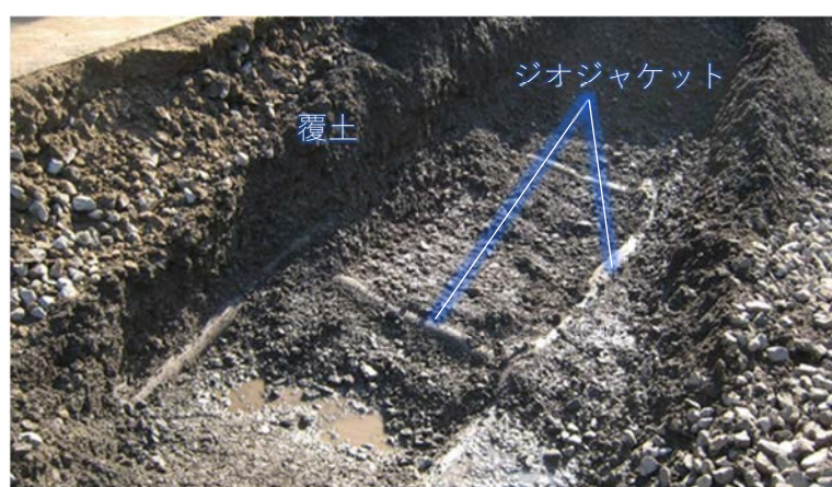
図 2.3.1.1 供用後のジオジャケットの状況 (表 2.3.2.1 中、施工現場 A)
