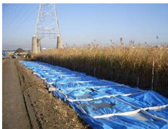
図 3.5.1.1 工事用道路への適用事例 (No.1)
