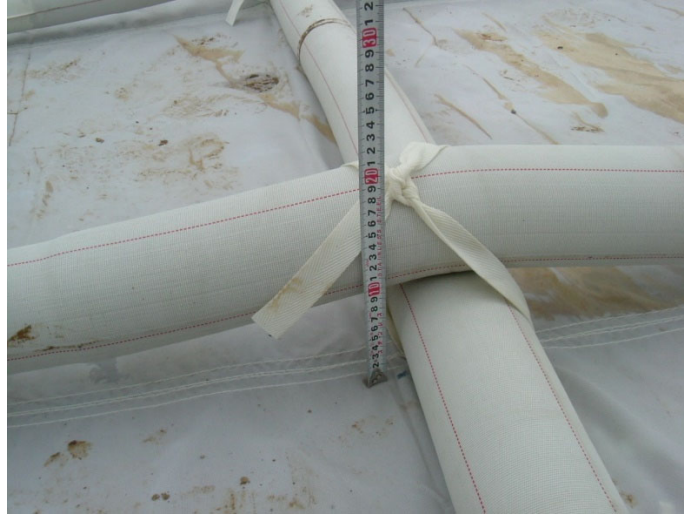
図 3.3.3.2 ジオジャケットの交差部の状況
