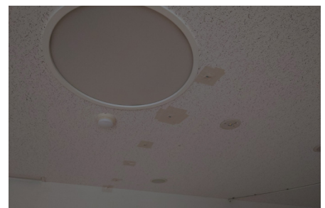
図 5-2-7 2階多目的室 天井の金具
