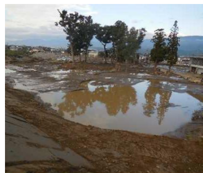
図 1.13 堤防背の洗堀の状況 17)
