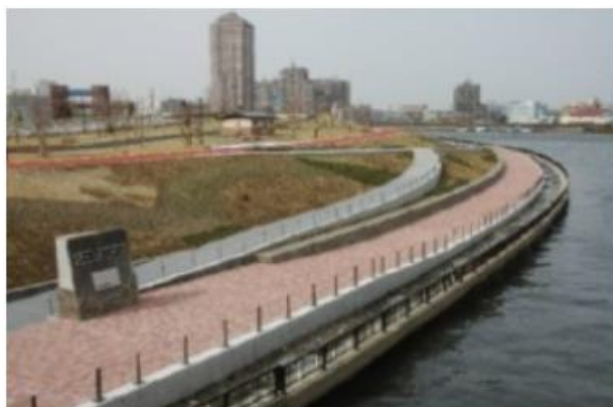
図 1.15 スーパー堤防完成部 (隅田川白鬚西地区) 21)
