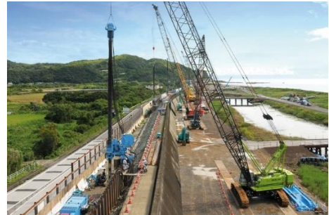
図 1.4 鋼矢板による海岸堤防改良工事 6)
