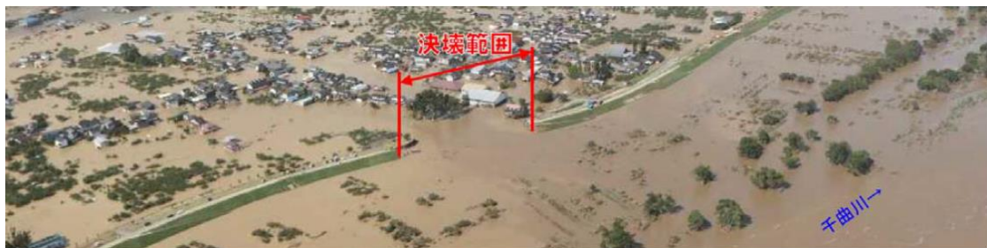
図 1.11 千曲川左岸58k 付近の航空写真 17)
