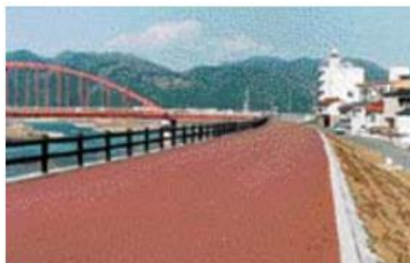
図 1.16 アーマーレビー完成部分 (馬洗川左岸 (OK800) ) 22)
