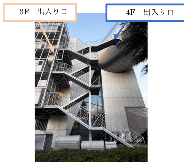
図2 屋外鉄骨避難階段 全景
